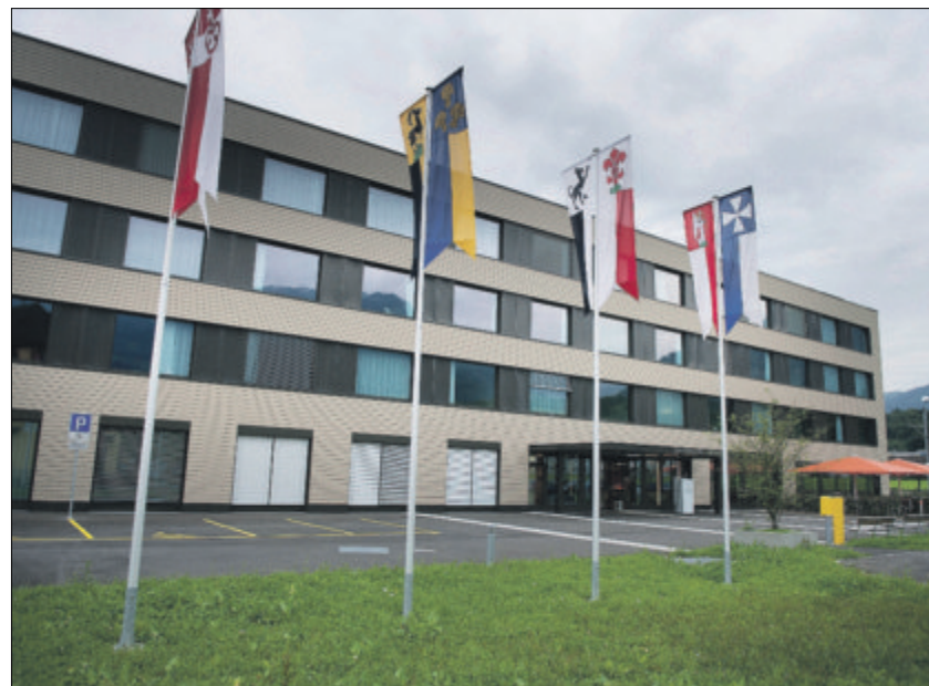
Die Wege trennen sich: die Kantonsspitäler Nidwalden (links) und Obwalden.
